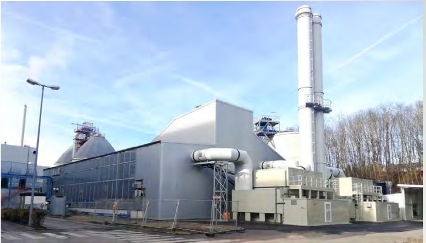
项目地: Sewage sludge drying, 德国 | 型号: 2x BTU 1/6200-36-4/4 | 安装年份: 2020 干燥物料: 市政污泥 | 蒸发量: 12.5吨/小时
