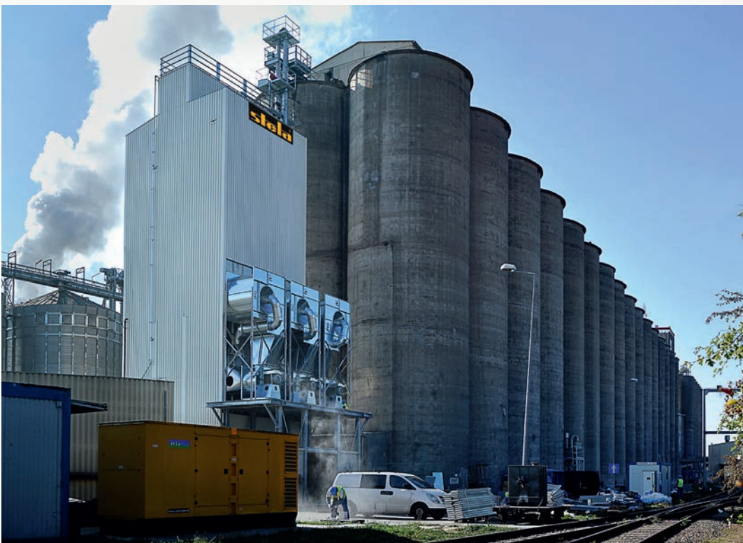
Bioagra S.A. 波兰, Nysa 型号: MDB-XN 3/18-SB 安装年份: 2015年 干燥物料: 玉米 干燥能力: 45.0吨/小时 降水区间: 35%-15%
